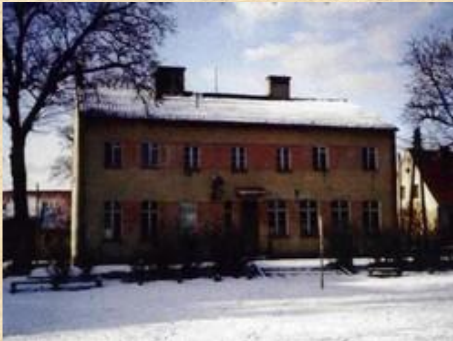
Budynek szkolny po przebudowie w 1977 roku
